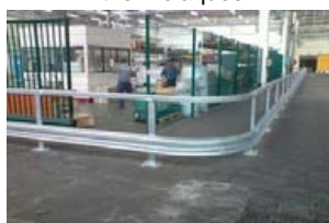
Gestion des angles finition galvanisée
